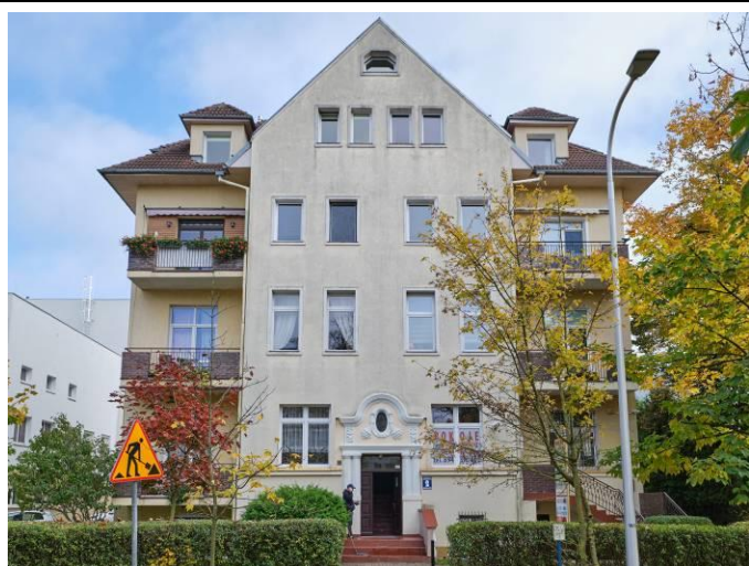
Elewacja frontowa - zachodnia
