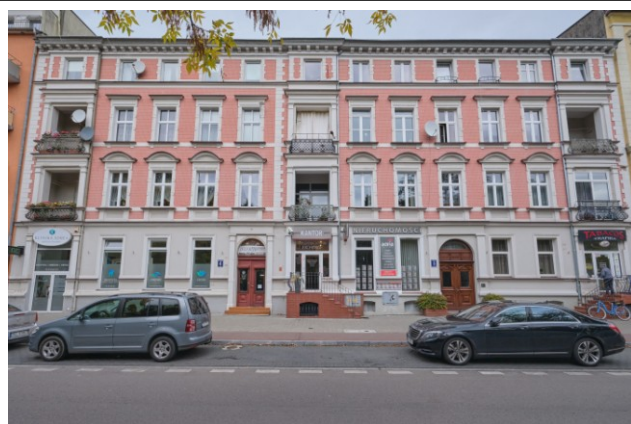
Widok elewacji frontowej od strony południowej
