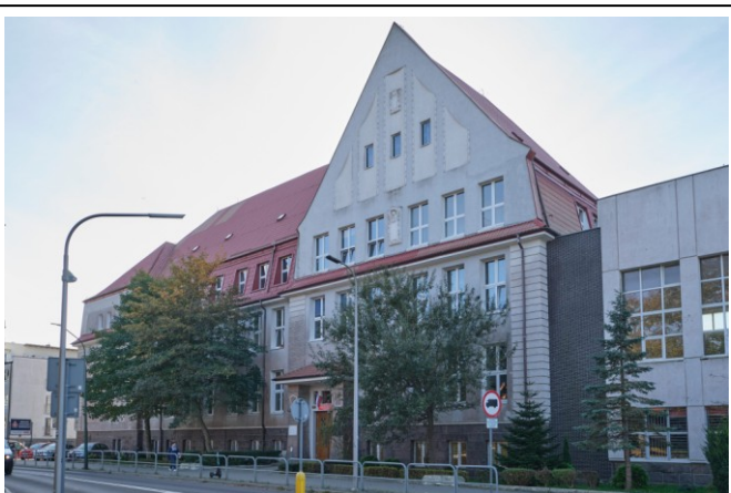
Widok ogólny bryły od strony północno-zachodniej
