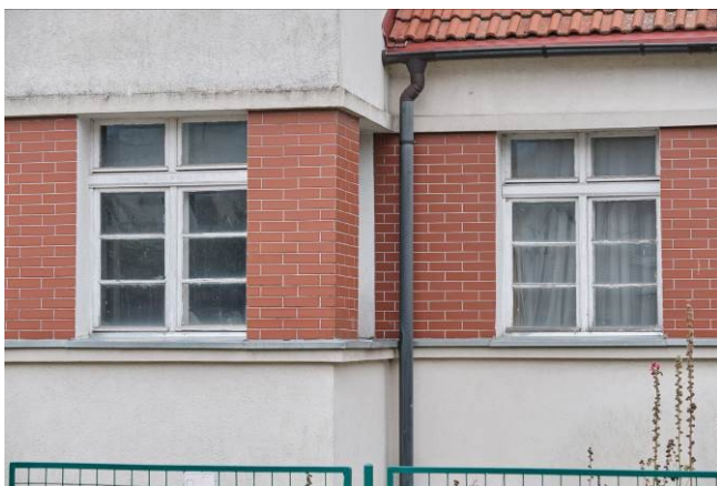
Oryginalne okna skrzynkowe w elewacji frontowej
