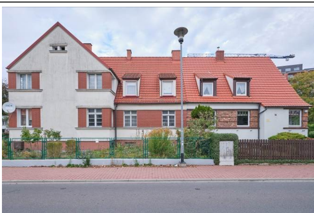
Elewacja frontowa, południowo-zachodnia
