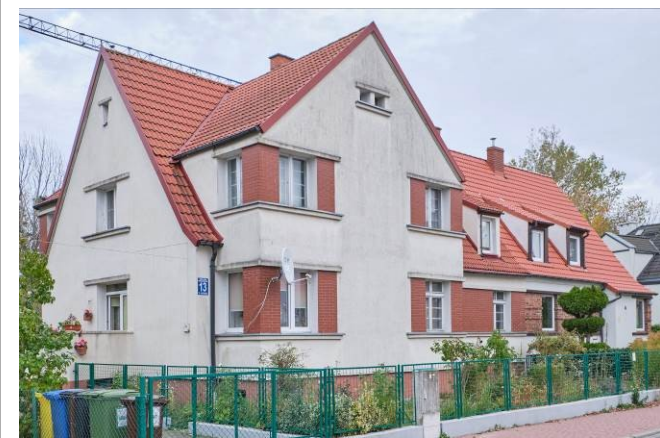
Widok ogólny bryły od strony zachodniej
