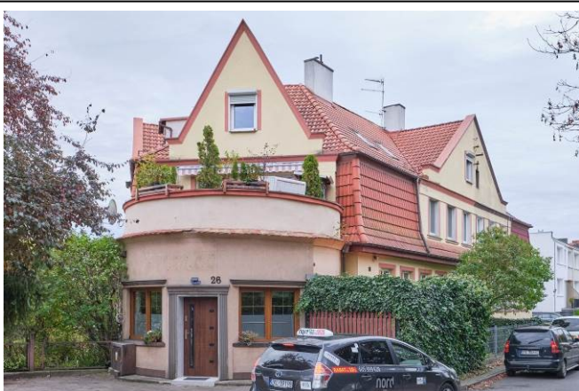
Szczyt budynku od strony wschodniej
