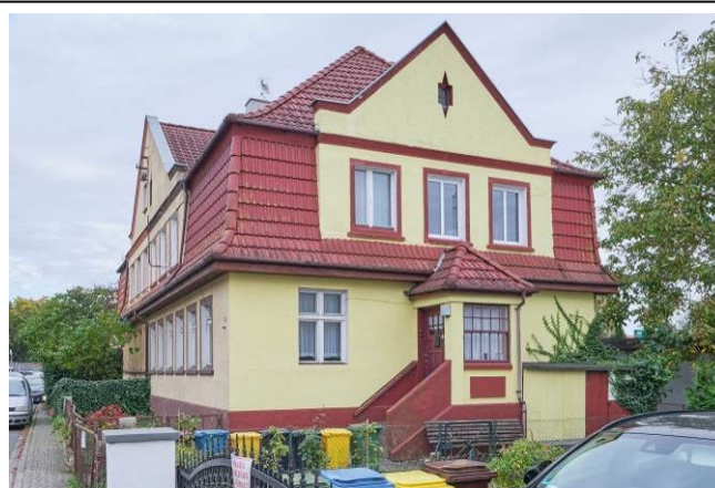
Widok ogólny bryły od strony północno-zachodniej
