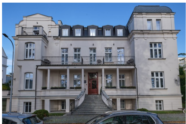
Widok elewacji frontowej od strony południowej
