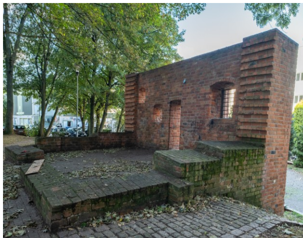
Widok ogólny ruiny baszty i murów od północnego wschodu
