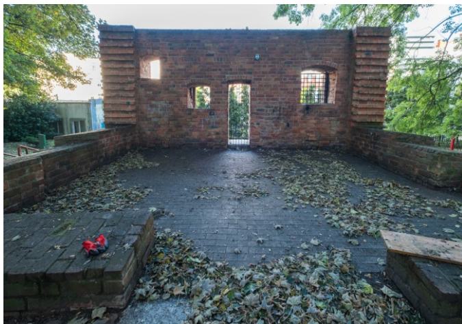
Widok ogólny ruiny baszty i murów od wschodu
