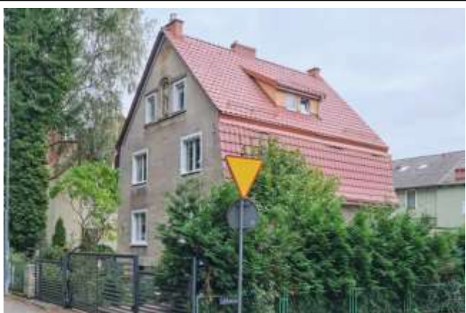
Widok ogólny bryły od strony północno-zachodniej
