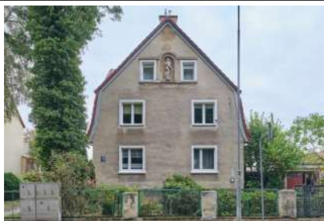
Północna elewacja szczytowa
