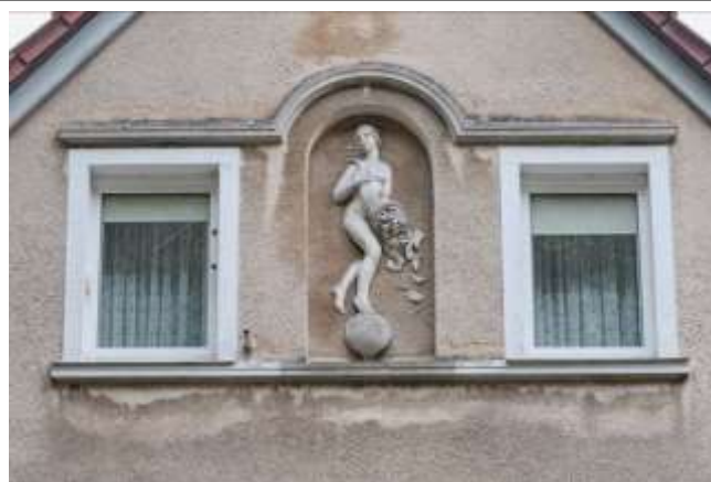
Rzeźba „kobiety z rogiem obfitości” w szczycie elewacji północnej
