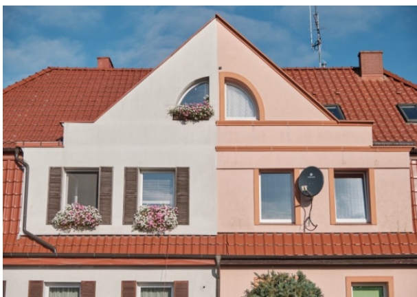
Wystawka elewacji frontowej
