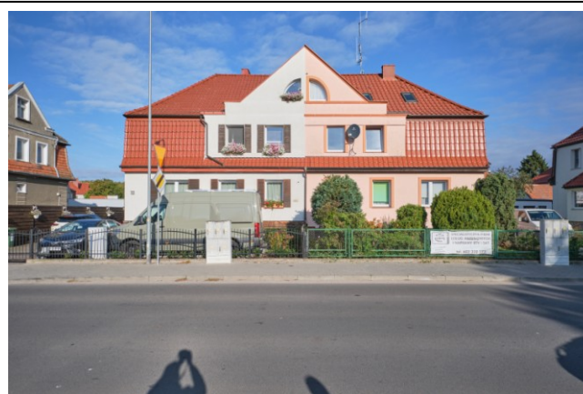
Widok elewacji frontowej, południowej
