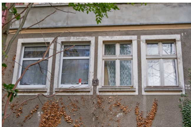
Widok okien elewacji bocznej
