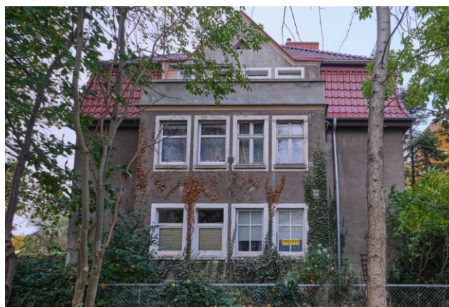
Widok na elewację boczną od wschodu
