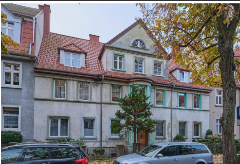
Widok ogólny bryły od strony płn.-wschodniej
