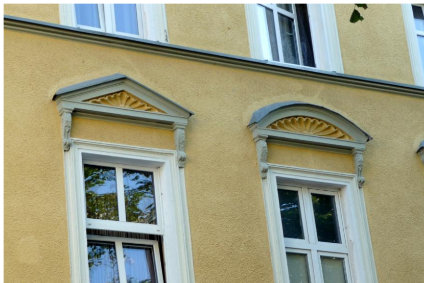
Otwory okienne w elewacji frontowej
