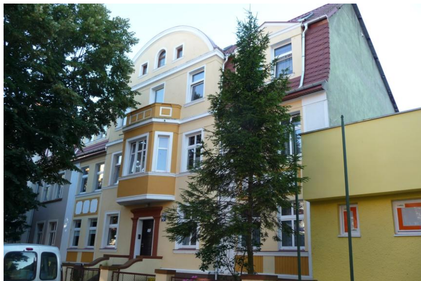
Widok budynku od północnego-wschodu
