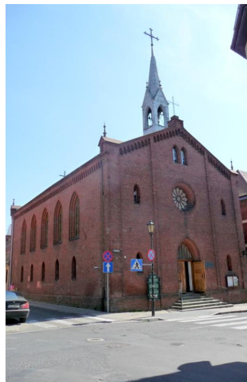
Widok budynku od północy
