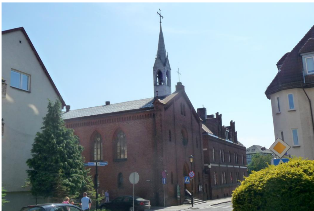
Widok budynku od północnego-wschodu
