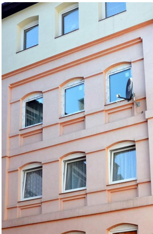
Otworki okienne w elewacji południowo-wschodniej
