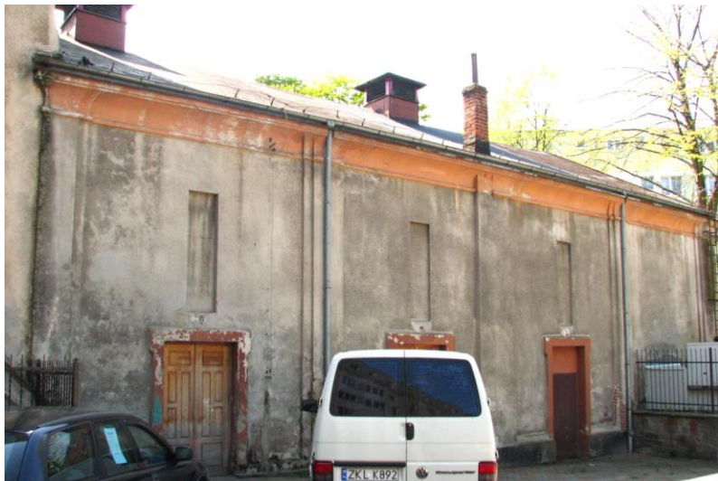
Widok budynku od północnego-wschodu
