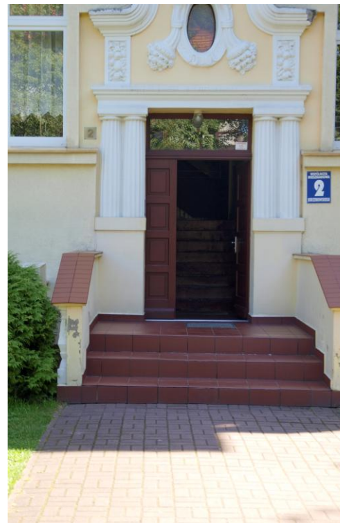
Portal drzwiowy w elewacji zachodniej
