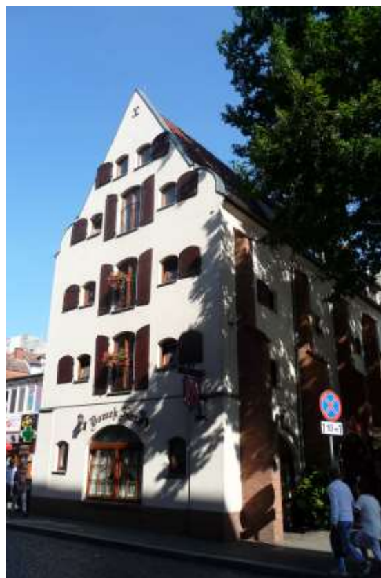
Widok budynku od południowego-zachodu
