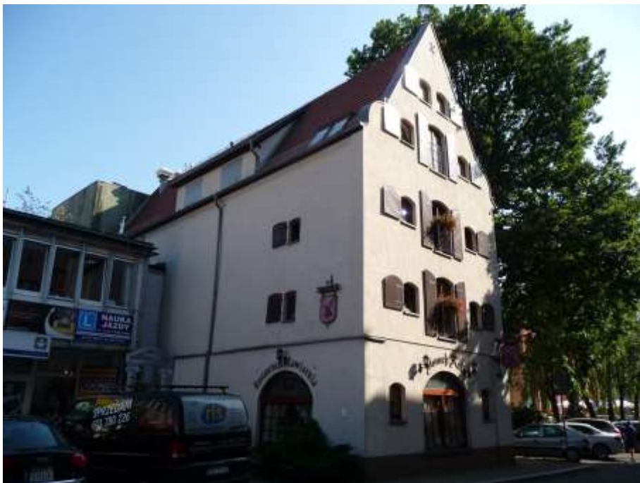
Widok budynku od północy
