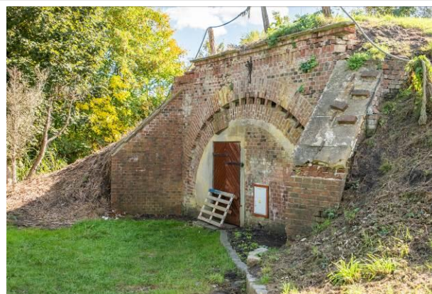
Schron amunicyjny w zachodniej części wału
