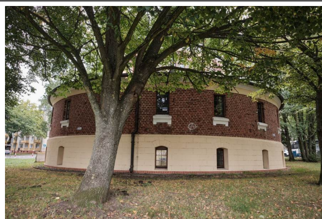
Widok ogólny bryły od strony południowo-zachodniej
