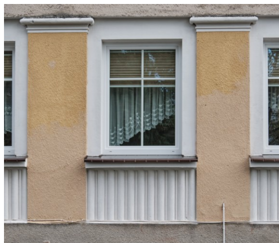
Okna w elewacji płd.-zachodniej
