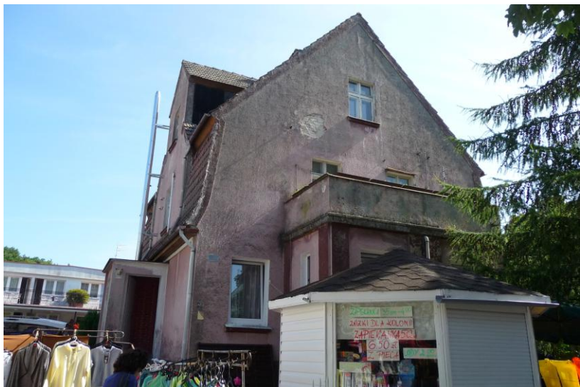
Widok budynku od południowego-zachodu
