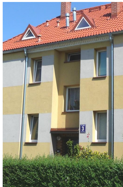
Część elewacji południowo-zachodniej
