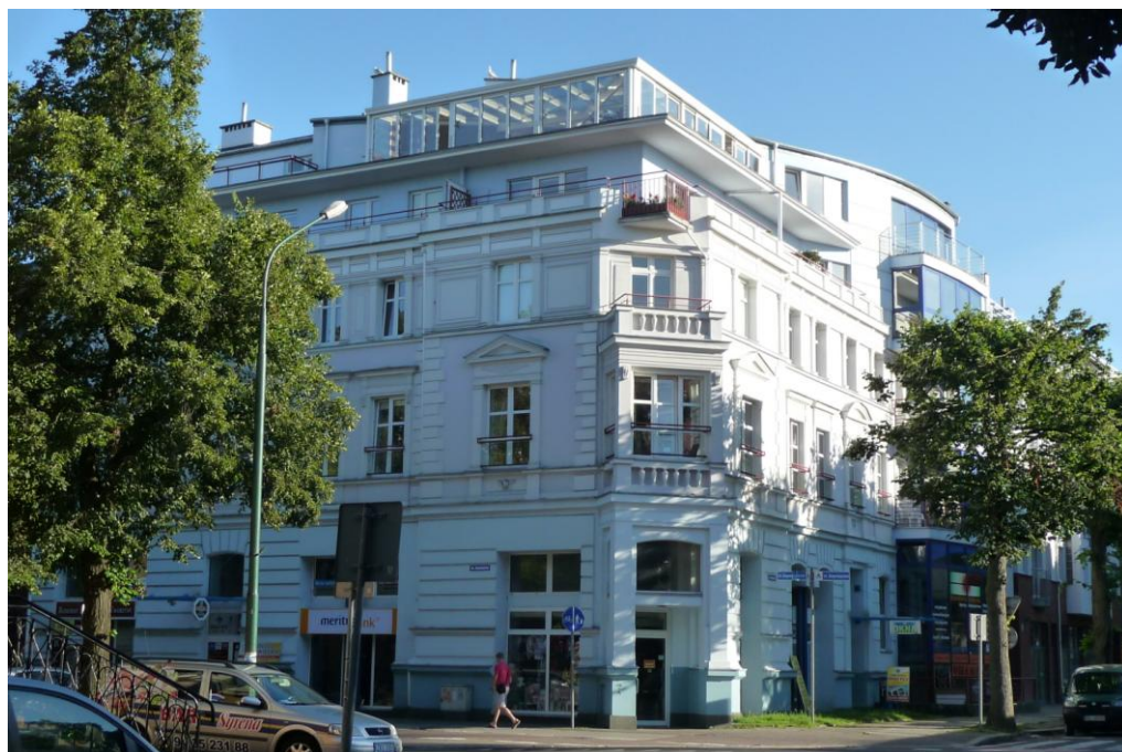
Widok budynku od północy
