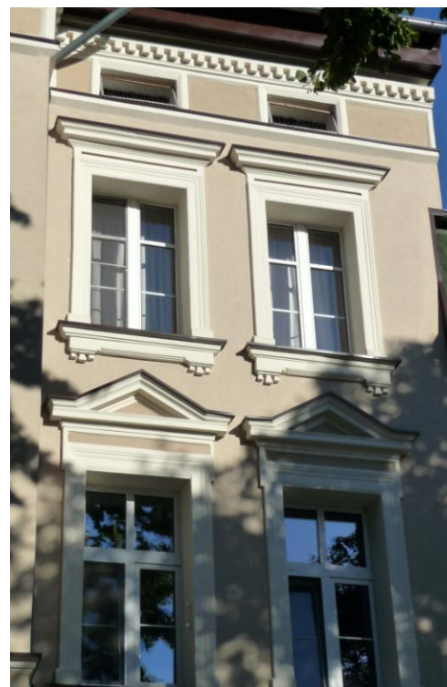
Otwory okienne w elewacji zachodniej
