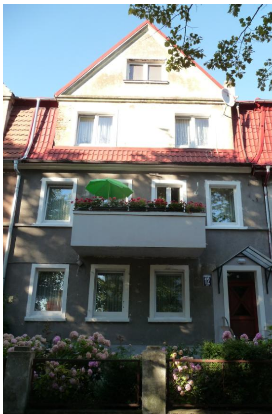
Widok budynku od południowego-zachodu
