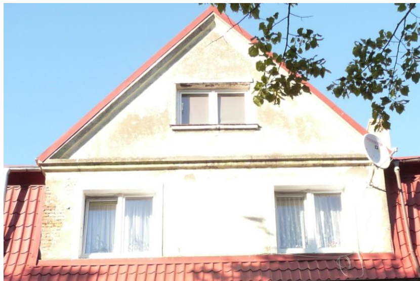
Facjata na frontowej połąci dachu
