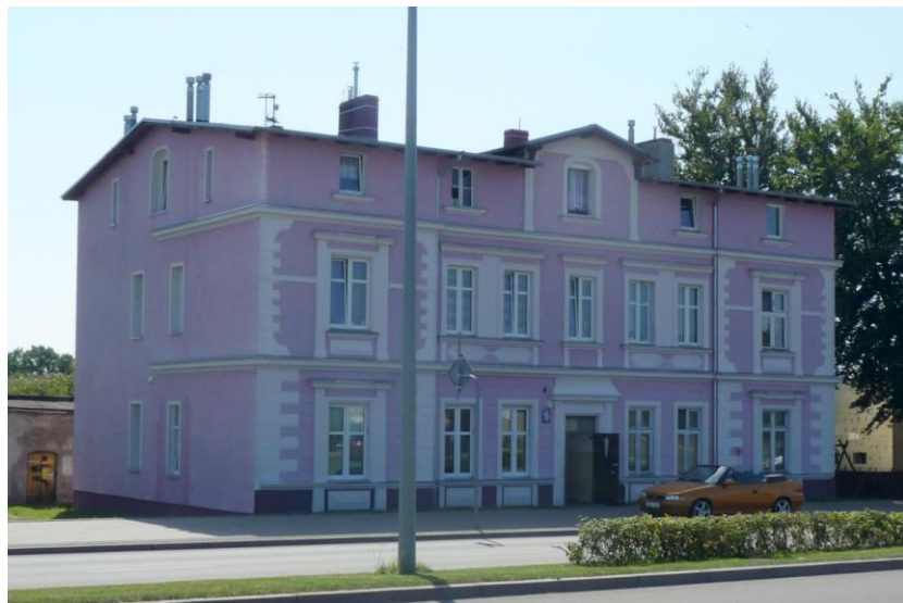
Widok budynku od północnego-zachodu
