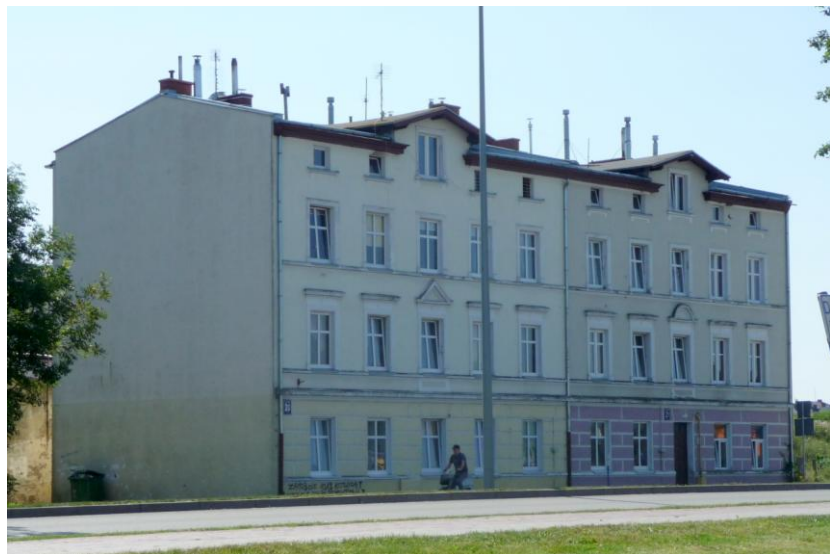
Widok budynku od północnego-zachodu
