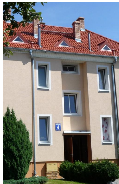
Część elewacji południowo-zachodniej
