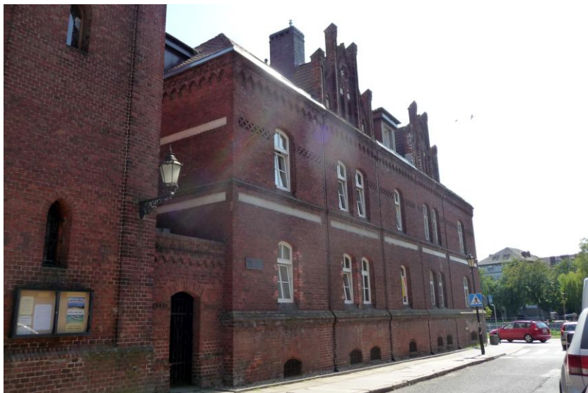
Widok budynku od północy
