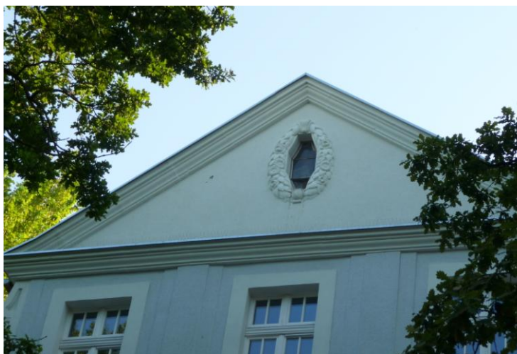
Szczyt elewacji północno-wschodniej
