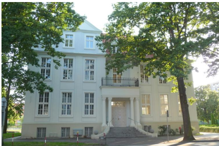
Widok budynku od północnego-wschodu
