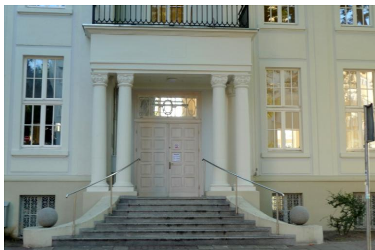
Wejście w elewacji północno-wschodniej
