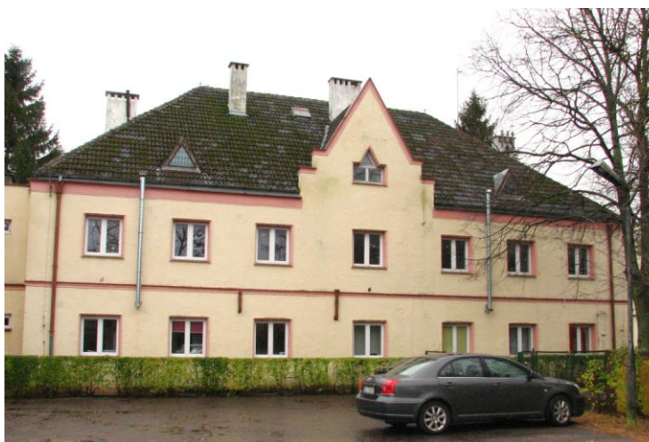
Widok budynku środkowego od północnego-zachodu
