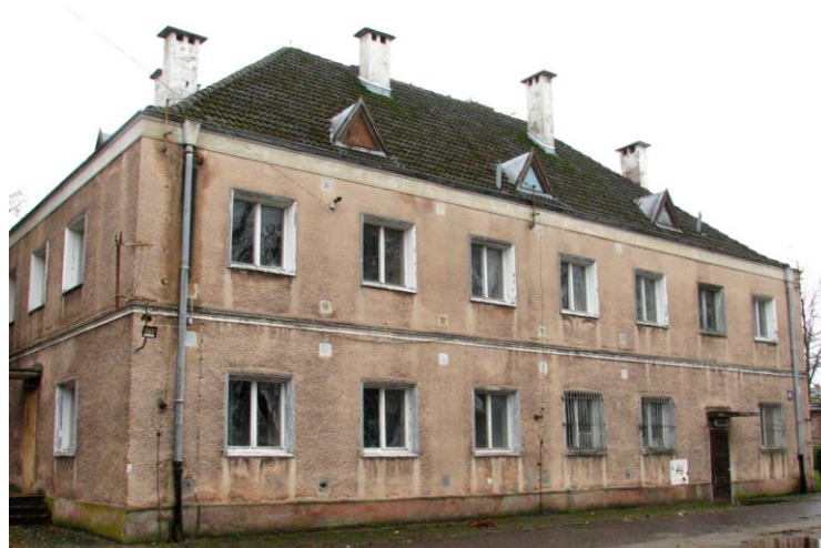
Widok budynku północnego od północnego-wschodu
