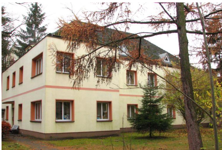
Widok budynku południowego od północnego-wschodu
