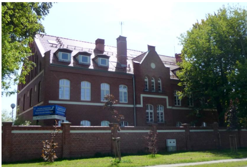
Widok budynku od północnego-zachodu
