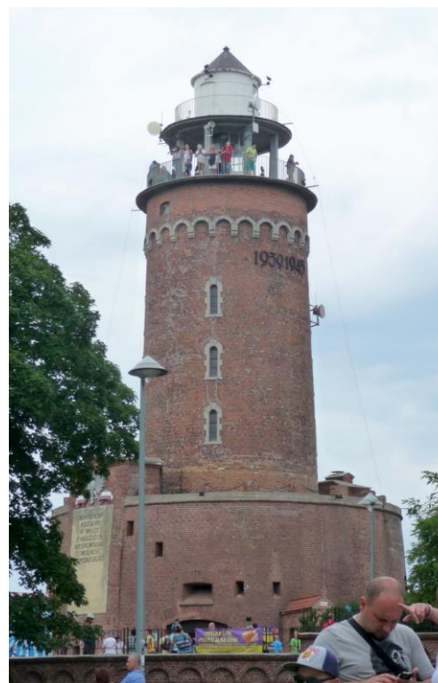
Widok budynku od południowego-wschodu
