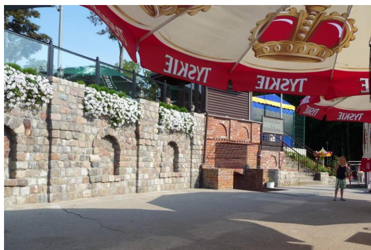
Widok budynku od północnego-zachodu
