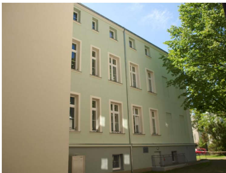
Widok budynku od północy
