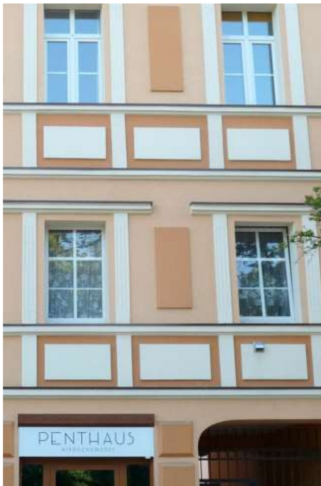
Otwory okienne elewacji frontowej
