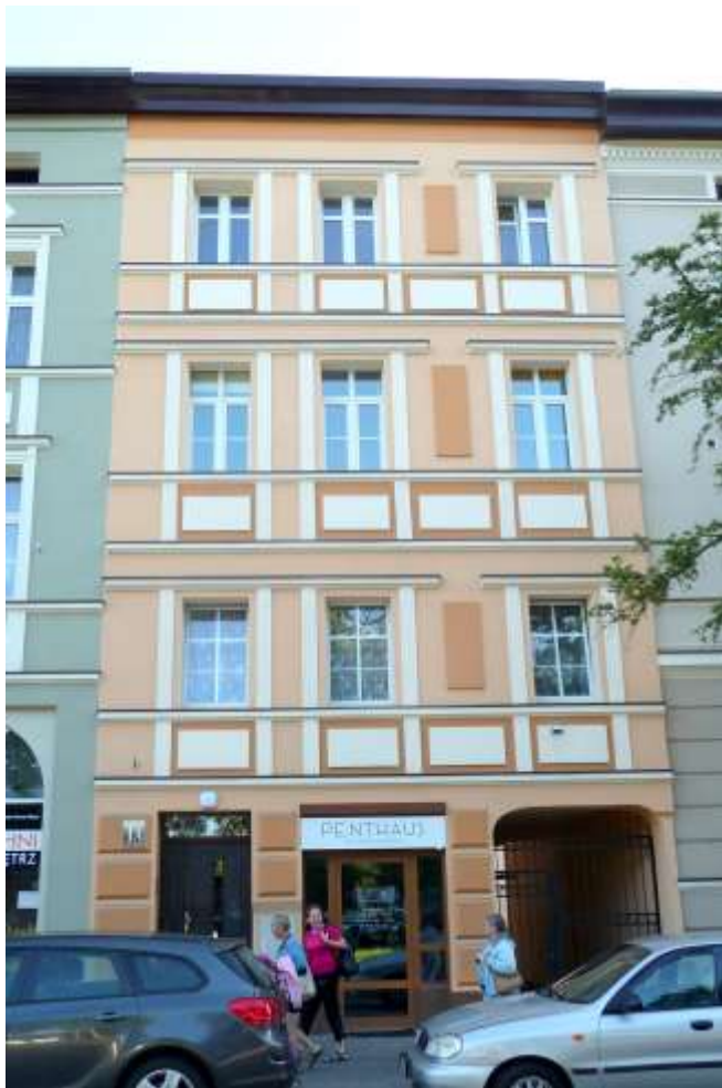
Widok budynku od północy
