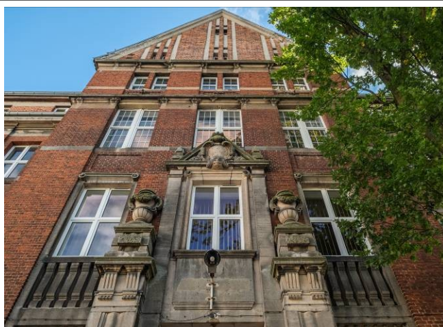
Fasada, ryzalit środkowy, fragment górnej części portalu
