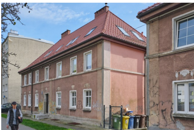
Widok ogólny bryły od strony północno-zachodniej
