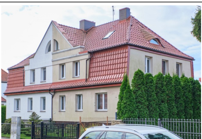
Widok ogólny bryły od strony północno-zachodniej
