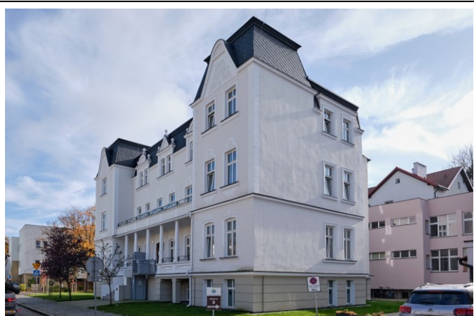
Widok ogólny bryły od strony północno-zachodniej
