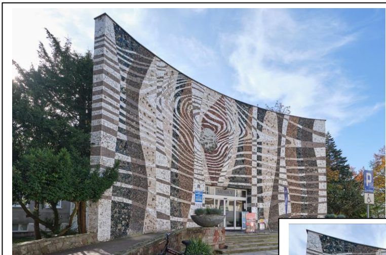
Widok boczny mozaiki od północnego zachodniej
