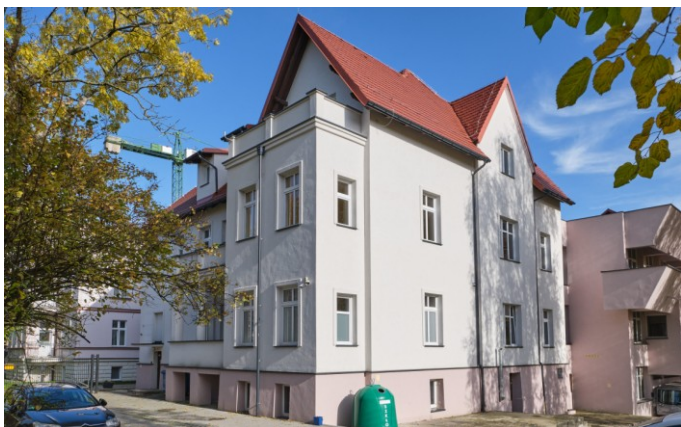
Widok ogólny bryły od strony południowo-zachodniej
