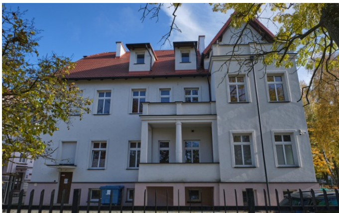
Widok elewacji frontowej, zachodniej
