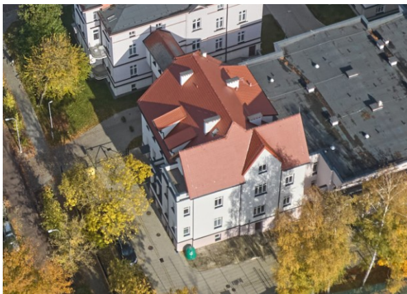
Widok z lotu ptaka, od strony południowo-zachodniej
