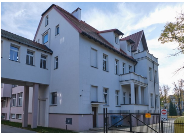
Widok ogólny bryły od strony północno-zachodniej
