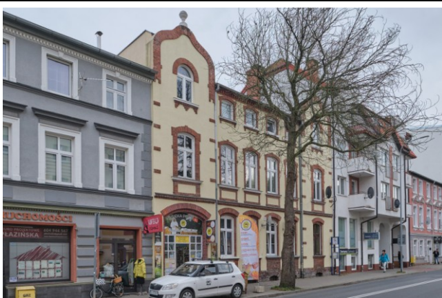
Widok ogólny bryły od strony północno-zachodniej
