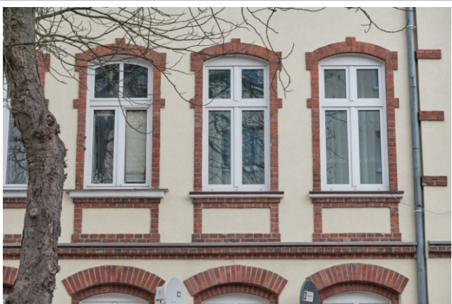
Fasada, detale wystroju architektonicznego
