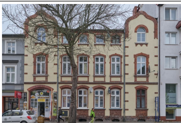
Widok na elewację frontową zachodnią
