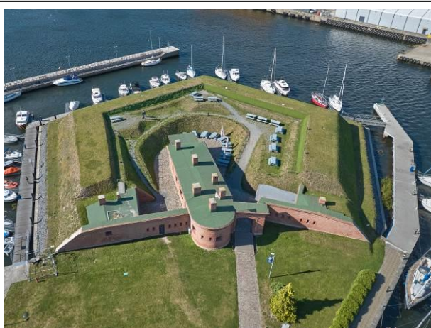
Widok ogólny z lotu ptaka od zachodu
