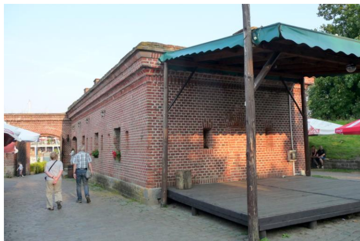
Widok budynku od północnego-zachodu
