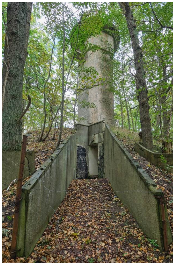
Schron stacji radiolokacyjnej z wieżą
