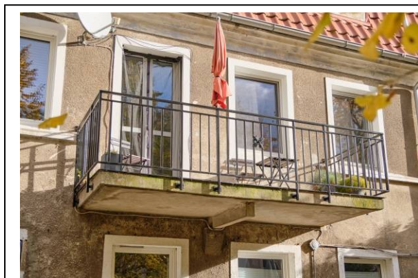
Widok na drugą kondygnację kamienicy z balkonem
