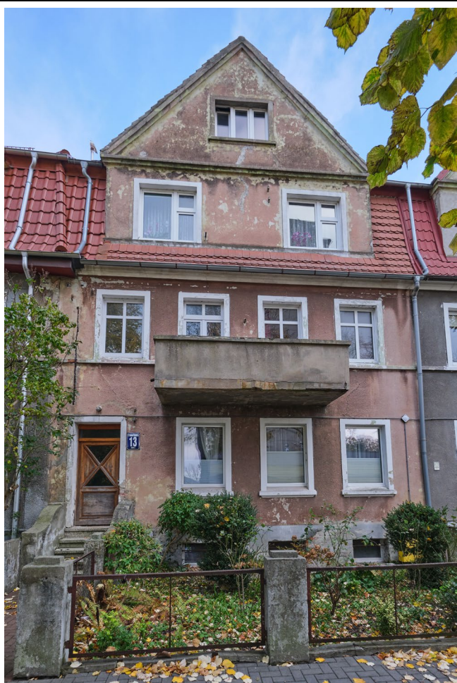
Widok elewacji frontowej
