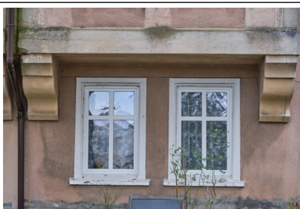
Widok na okna parteru
