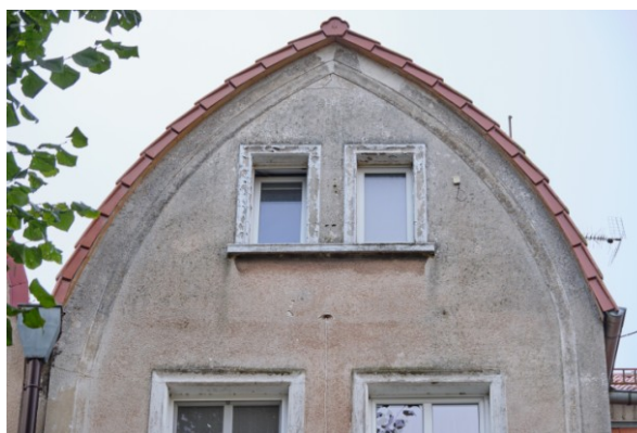
Widok na szczyt wykusza
